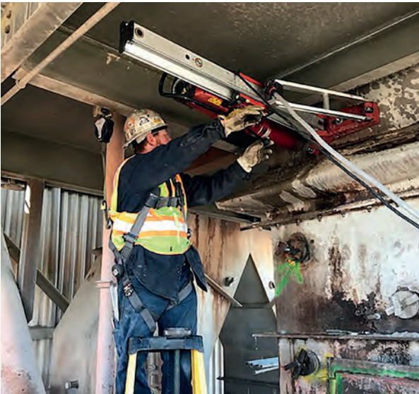
Yeni teknoloji, hava şoklarının proses duruşu olmadan kurulmasına ve bakımının yapılmasına olanak tanıdı.
