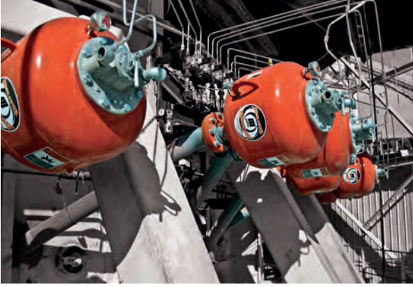
Bir dizi hava şoku, maksimum fayda için tam zamanlı operasyon sağlamak üzere programlanabilir.
